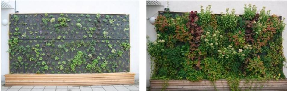
Abbildung 1: Beispiel - wandgebundene Vertikalbegrünung mit vollflächigem Vegetationsträger – links: kurz nach der Bepflanzung (Sommer 2017); rechts: zwei Jahre nach der Bepflanzung (Sommer 2019).
