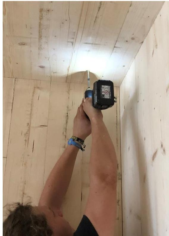
Abbildung 7: Kopplung mit Teilgewindeschrauben
