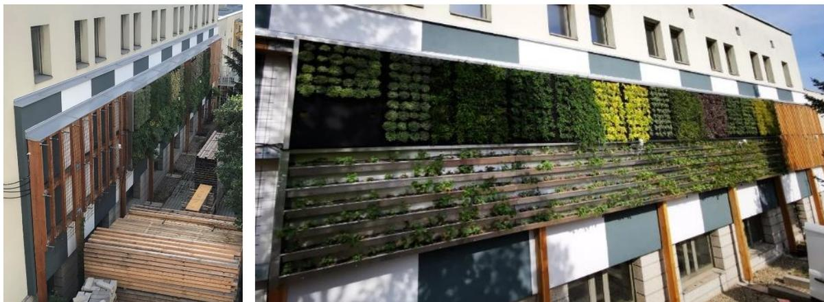
Abbildung 9: Forschungsfassade mit unterschiedlichen Begrünungssystemen an einer Holz-Unterkonstruktion, umgesetzt am Camillo Sitte Bautechnikum in Wien im Rahmen des Forschungsprojekts MehrGrüneSchulen [17]
