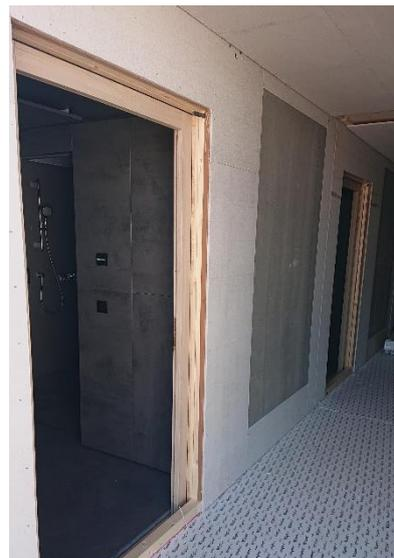
Abbildung 4: Revisionsöffnung zum Installationsschacht
