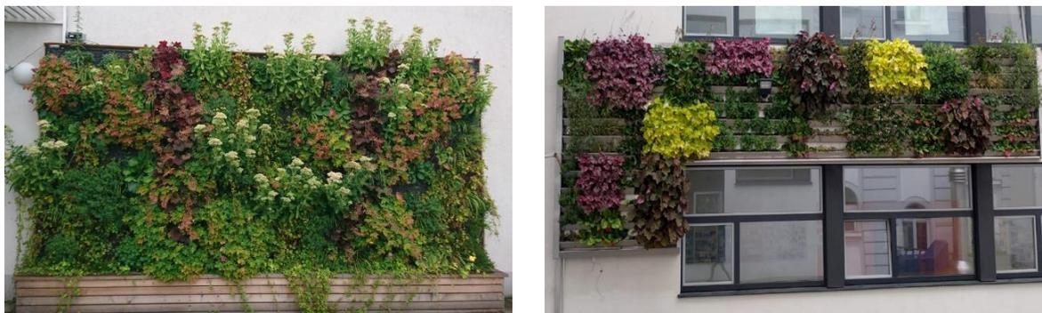
Abbildung 6: Kassettsystem am BRG15 Diefenbachgasse (li) und Trogsystem am BRG16 Schuhmeierplatz (re).
