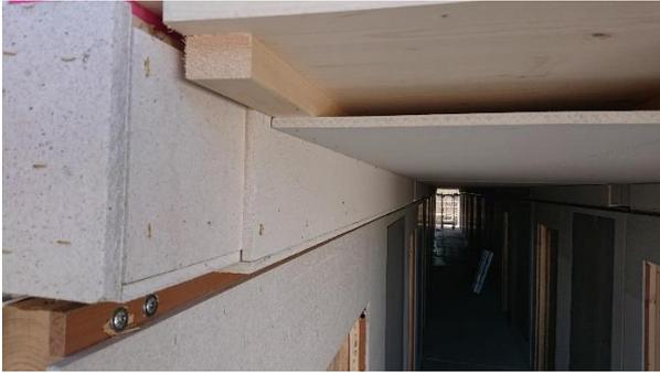
Abbildung 13: Auflagerkonsolen für Flurdecken-Elemente
