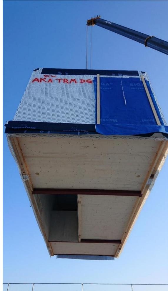
Abbildung 14: Montage eines Treppenmoduls
