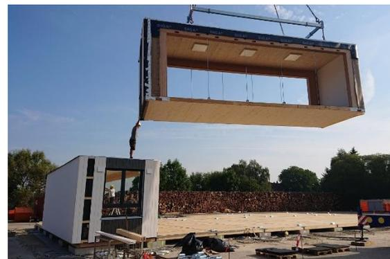
Abbildung 16: Montage eines Gewerbemoduls
