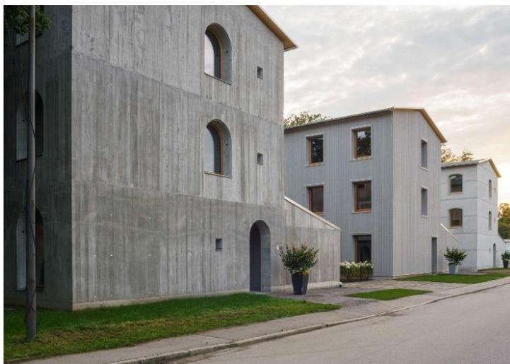
Abbildung 4: Straßenansicht der drei Forschungshäuser. Die unterschiedlichen Fensterformen entsprechen dem Außenwandmaterial. Foto: Sebastian Schels
