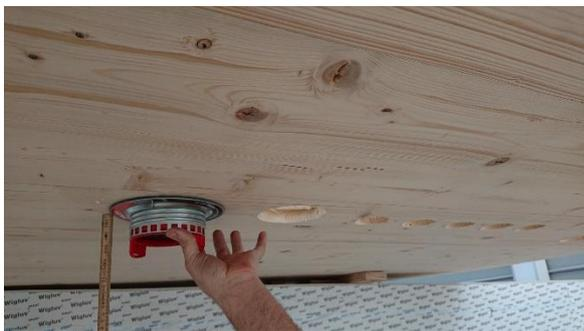
Abbildung 7 c: Einbau BS-Hülse
