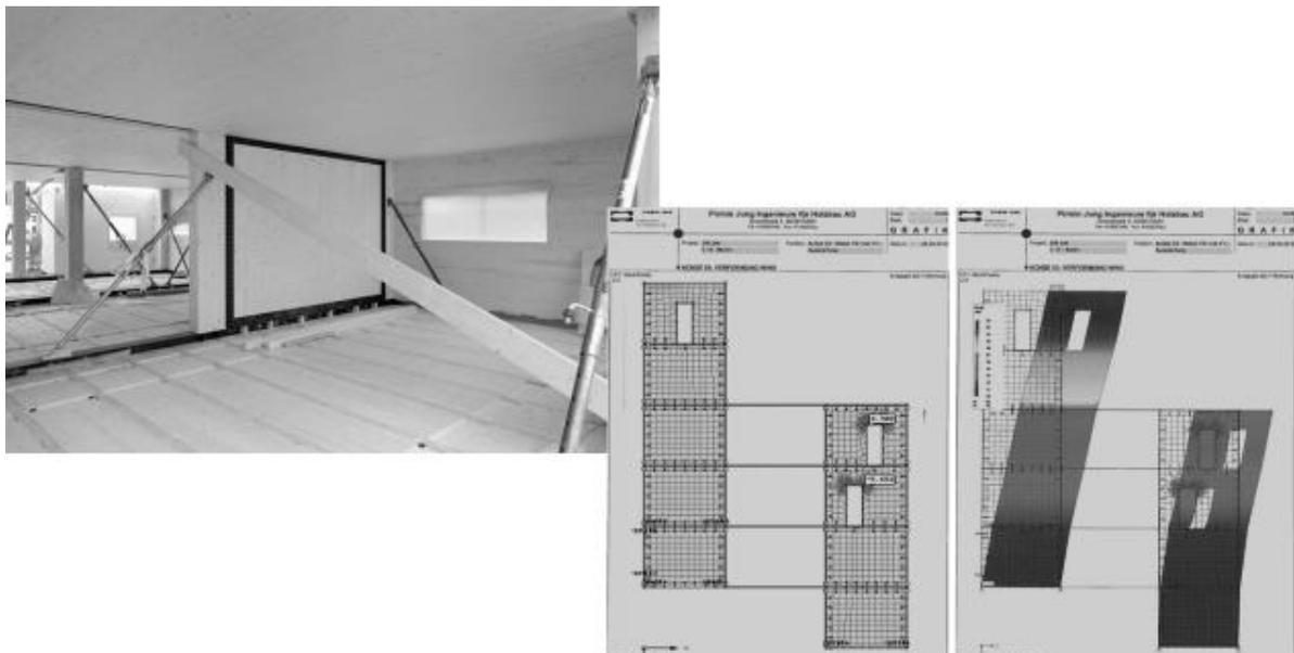
Abbildung 21: Links: Baustellenfoto mit einer in den Hauptstützen und in den Unterzügen eingespannten Brettsperrholzplatte. Rechts: Auszug aus der statischen Bemessung bezüglich der Bemessung dieser aussteifenden Wand, die ein Teil des horizontalen Tragwerkskonzeptes ist.
