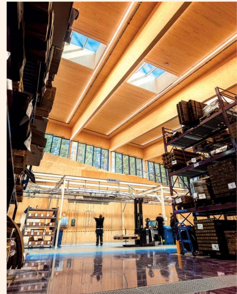
◀ Insgesamt wurden 36 Fensterelemente in den Neubau integriert – als zwölf Lichtbänder mit jeweils drei Modulen
