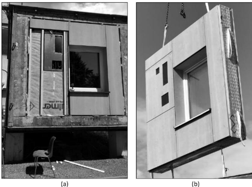
Abbildung 5: (a) Funktionsmuster einer vorgefertigten Holzfassade mit integrierter Außeneinheit der Heizungs-Lüftungswärmepumpe in der PASSYS Testzelle der UIBK und (b) während der Installation des Fassadenelements (Holzbau Kulmer)
