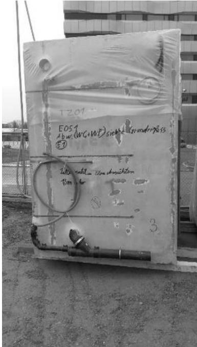
Abbildung 3: Anlieferung der vorgefertigten Sanitärzelle (Bild: ZURFLUH LOTTENBACH GMBH, Luzern)
