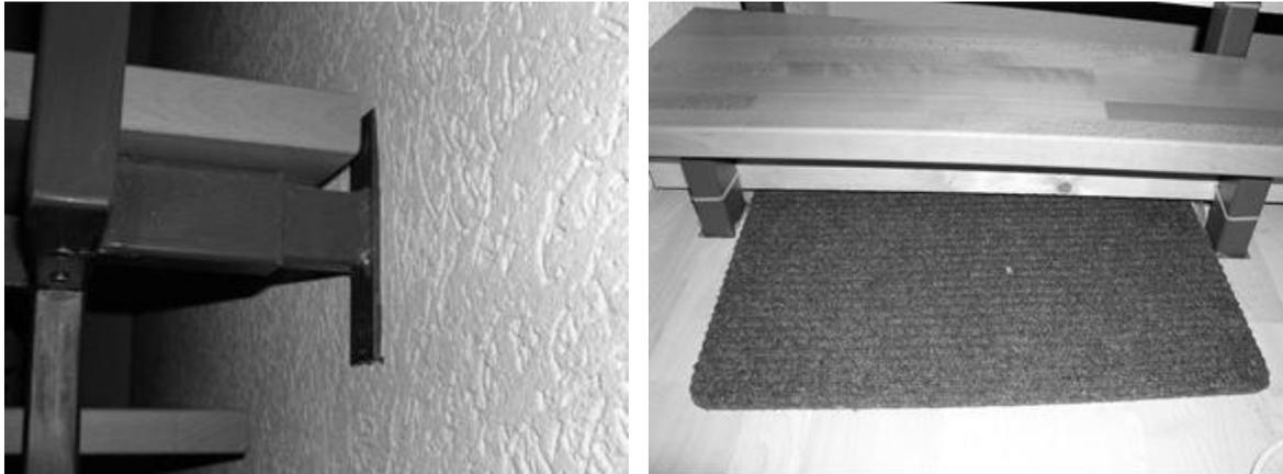
Abbildung 2: Ankopplungspunkte der 2 x Viertel-gewendelten Stahl-Harfen-Treppe an Haustrennwand und Boden. Die 14 massiven Holzstufen der Dicke 4 cm sind mit ca. 5 mm Gummiunterlage auf die Stahl-Wangen (Rechteck-Profile) geschraubt. Die Stahlwangen sind durch quer zur Laufrichtung angeschweißte Rechteck-Profile unterstützt. Diese sind an die Holzständer angeschraubt. Die Ankopplung an die Decke erfolgt über einen Stahlrahmen, der an die Deckenstirn angeschraubt ist.
