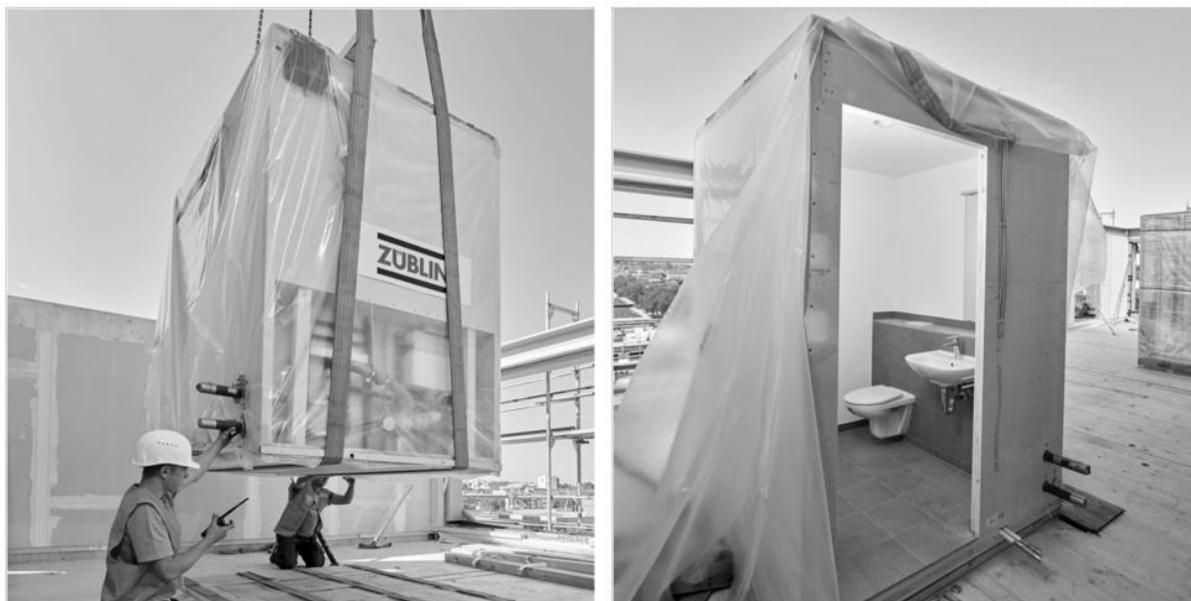
Abbildung 9: Badmodule mit Wänden aus Holz-Verbundwerkstoff
