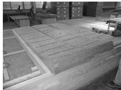
Abbildung 6: Gefachdämmung
