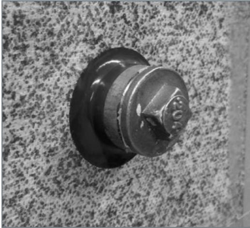
Rohrdurchführung mit Dichtmanschette
