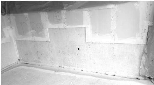
Abbildung 6: Pilzbefall - Oberflächenbehandlung mit H<sub>2</sub>O<sub>2</sub> und Kalk
