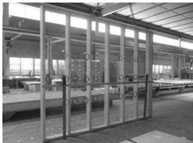
Abbildung 4: Vorfertigung der Holzrahmenkonstruktion mit Thermoelementen
