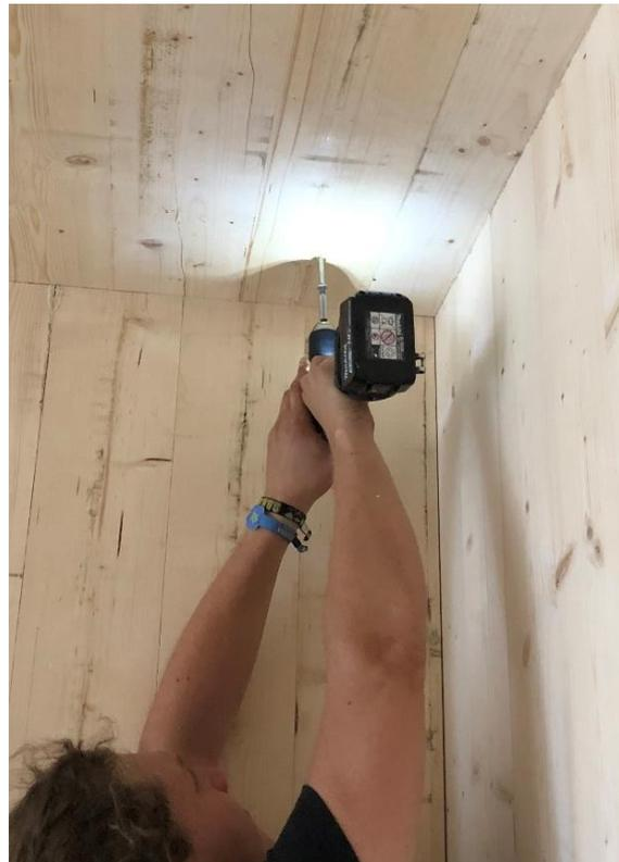
Abbildung 7: Kopplung mit Teilgewindeschrauben
