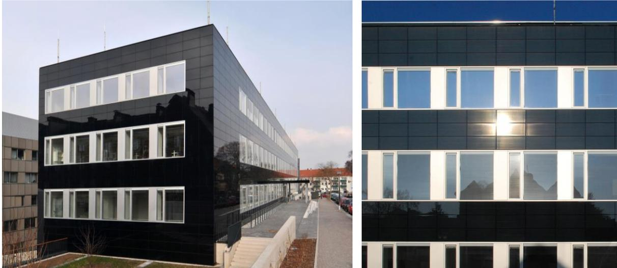
Abbildung 3: Hinterlüftete Photovoltaik-Fassade am Walther-Hempel-Bau der TU Dresden. (Foto: Bauko TUD.)
