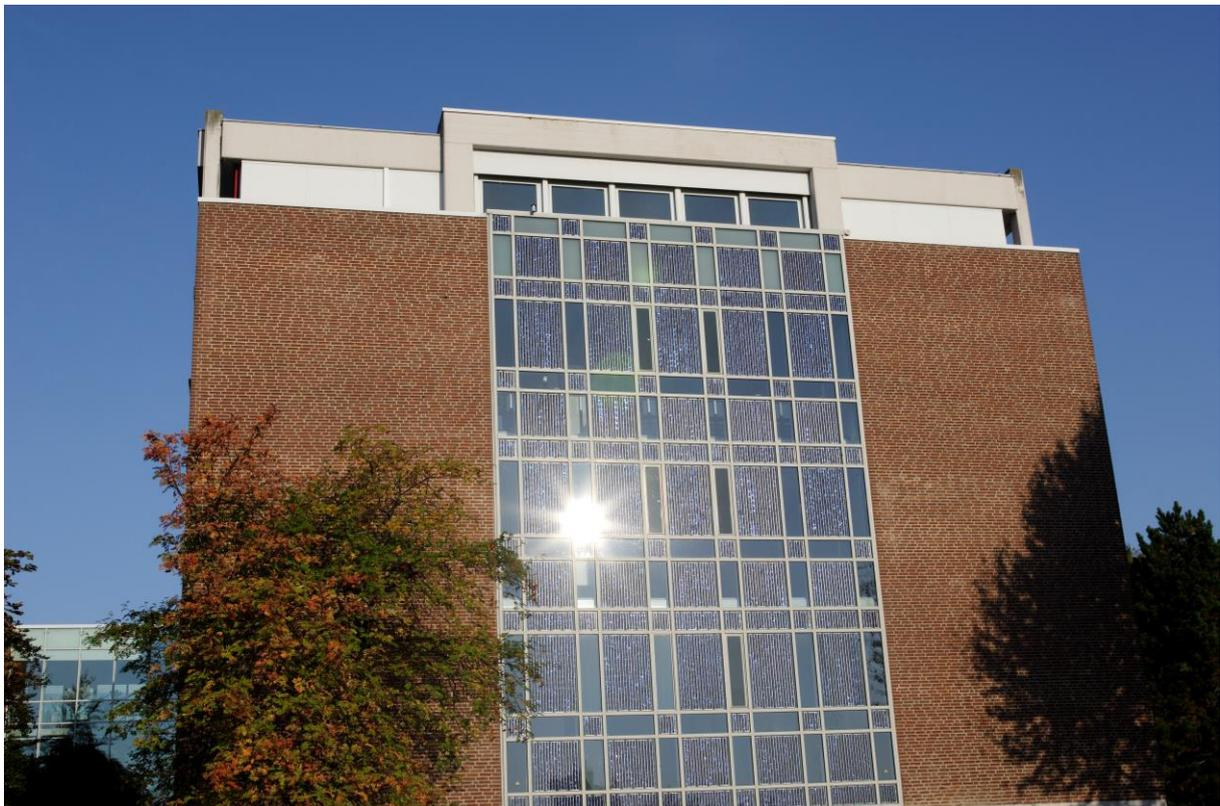
Abbildung 2: PV-Pfosten-Riegel-Fassade am STAWAG-Gebäude in Aachen. (Foto: STAWAG.)
