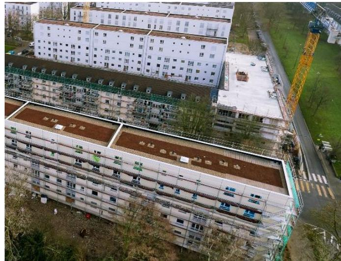
Die Aufstockung auf bestehende Gebäude ist durch die Weiterentwicklung der elementierten Fertigung hin zum Modulbau eine äußerst ökologische und effiziente Möglichkeit der Nachverdichtung
