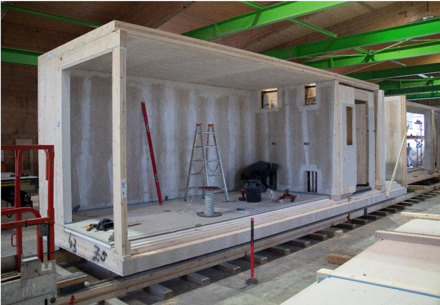
Die innerhalb eines Tages gefertigten Module werden sofort zum Gebäude versetzt
