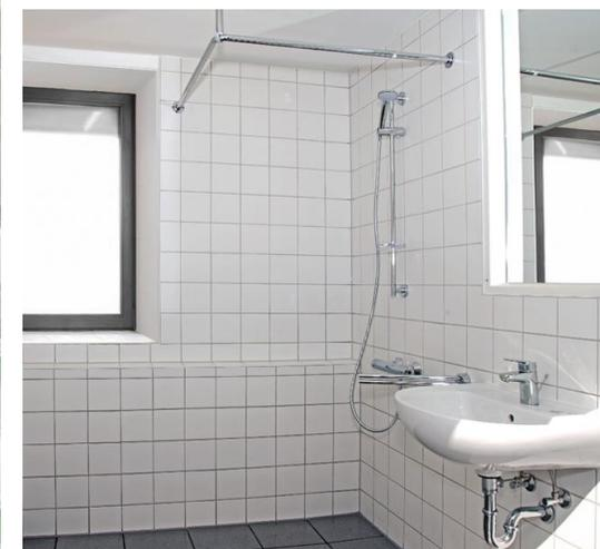
**Fertigbäder sind ein wesentlicher Bestandteil. Sie ermöglichen es, die Aufstockung in sehr kurzer Zeit umzusetzen**
