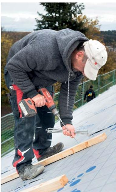
◀ Mit einer Konterlattung in 40 mm Dicke und passenden Systemschrauben fixierten die Dachhandwerker die PU-Hartschaumplatten auf dem Dach
