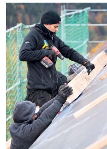
Im Traufbereich sorgen auf die Tragschale montierte Schubhölzer für die Begrenzung der Dämmschicht
