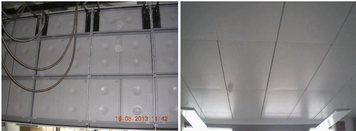
Abbildung 4: PCM-Kühldecken in den Büroräumen des EEC, links im geöffneten, rechts im geschlossenen Zustand.
