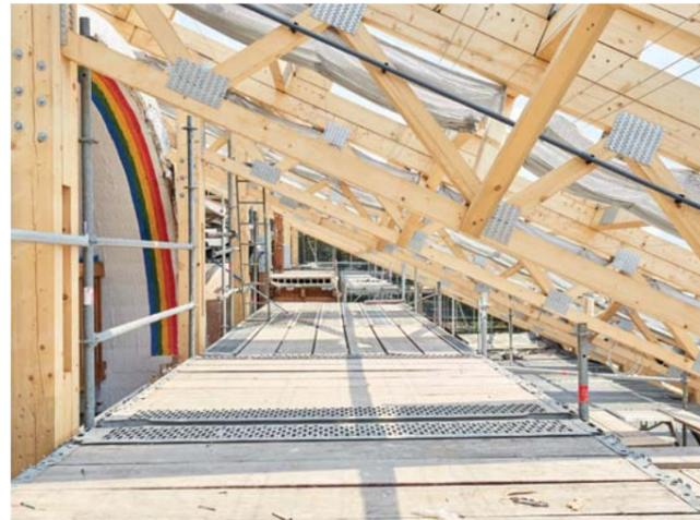
▲ An den Knotenpunkten der schlanken Binder sorgen eingepresste Nagelplatten für sichere Verbindungen
