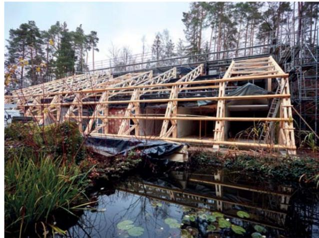
▲ Das industriell gefertigte filigrane Tragwerk aus Nagelplattenbindern verbindet Ökonomie und Ästhetik
