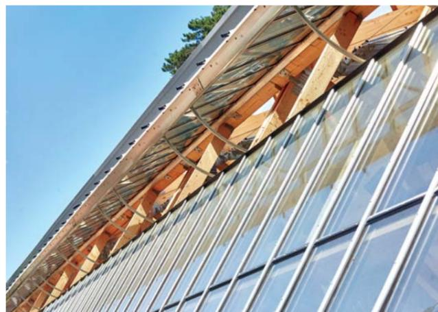
▲ Klappflügel im Trauf- und Firstbereich ermöglichen eine natürliche Querlüftung des Gebäudes
