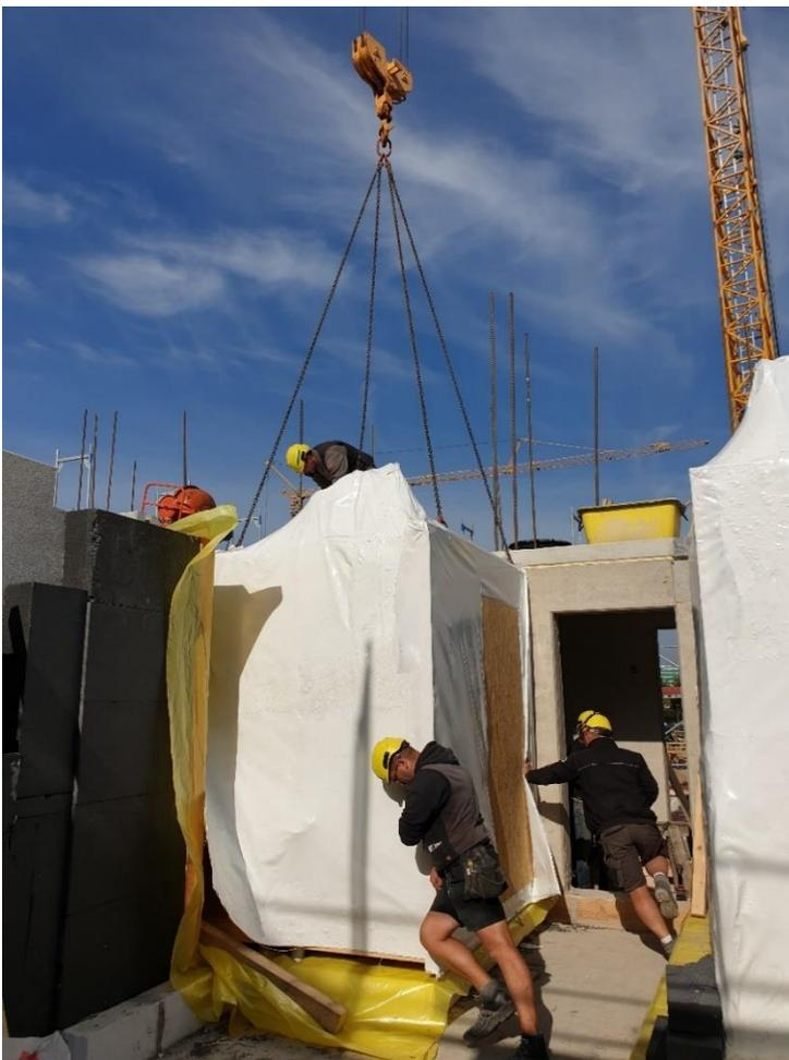
Abbildung 16: Montage Badmodul, Atelier PK Architekten
