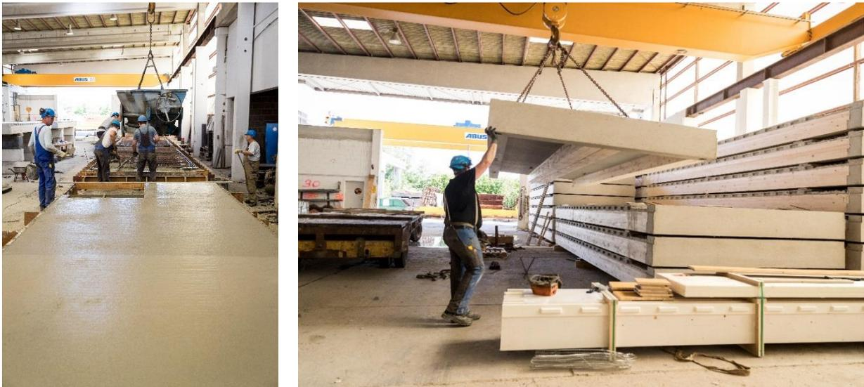
Abbildung 9: «Bürogebäude Handwerkerhaus» Bremen | Vorfertigung Decken | © CREE Deutschland GmbH
