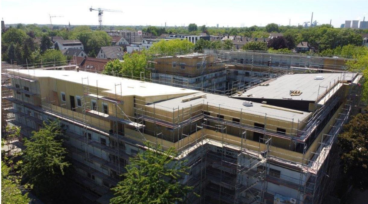
Abbildung 1: Aufstockung einer Blockbebauung [Ripkens Wiesenkämper Beratende Ingenieure PartGmbH]
