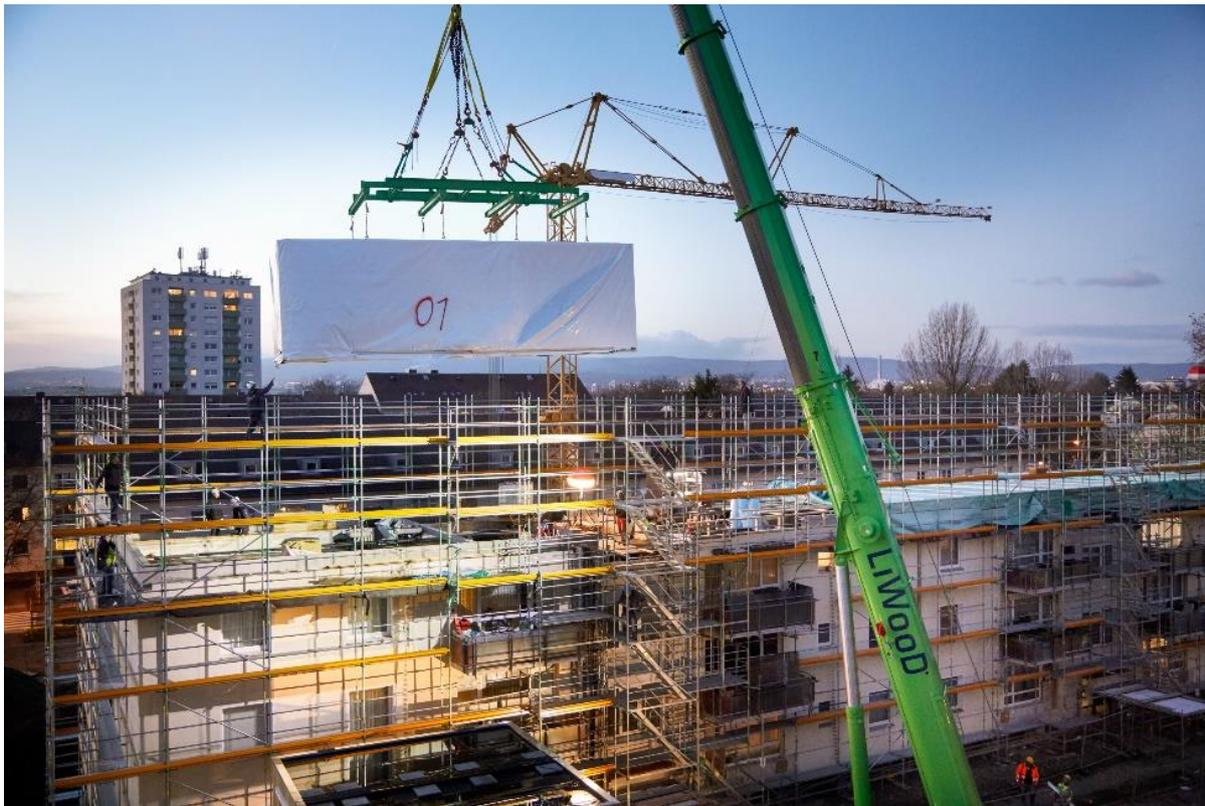
Abbildung 13: Versetzen des ersten Moduls von insgesamt 1.102m<sup>2</sup>
