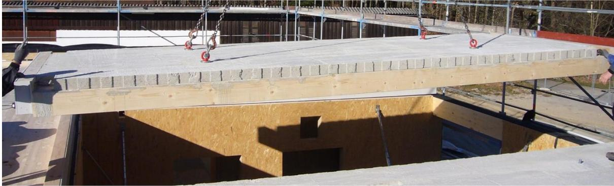
Abbildung 7: Montage der HBV-Decke als Vollfertigteil
