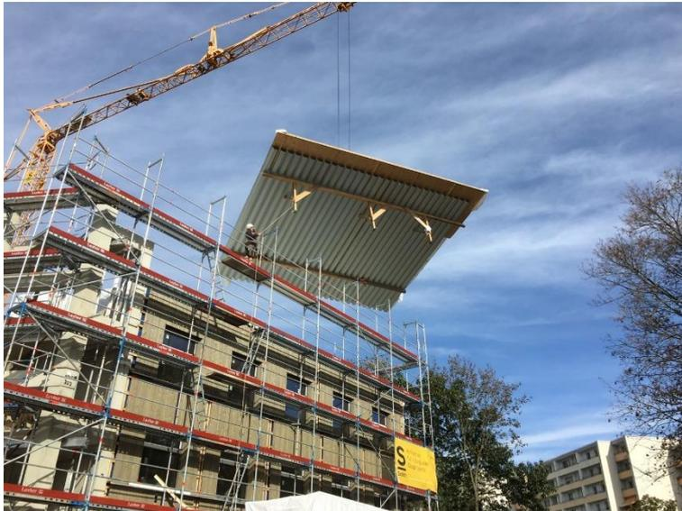
Abbildung 10: Behelfsdach, Gebr. Schütt KG (GmbH & Co.)
