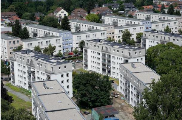
Abbildung 14: Blick auf die fertiggestellte eingeschossige Aufstockung
