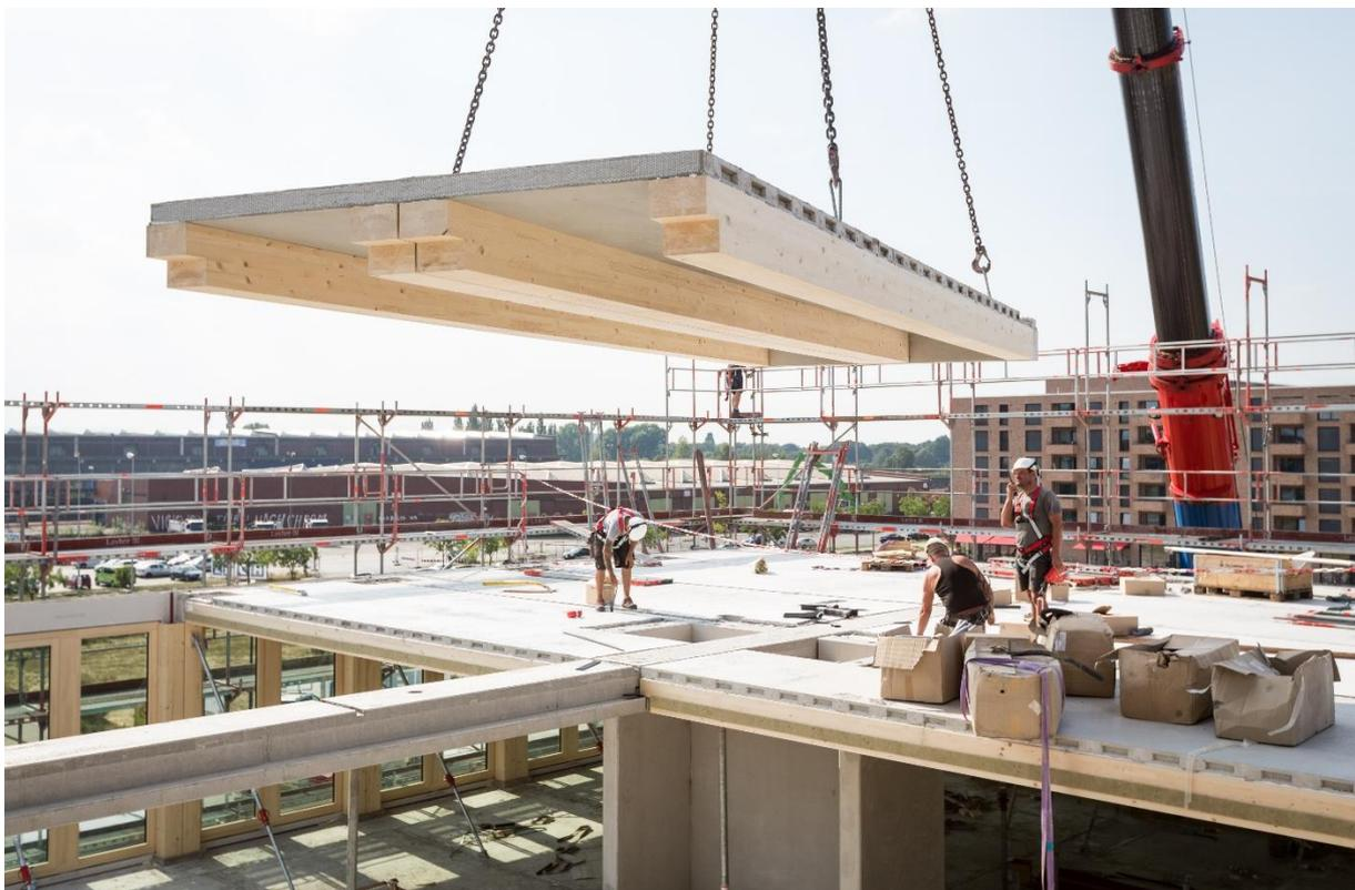
Abbildung 13: «Bürogebäude Handwerkerhaus» Bremen | Montage Deckenelement | © CREE Deutschland GmbH
