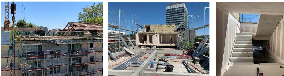
Abbildung 5, 6 und 7: (links) Abriss der Bestandsdächer, (Mitte) Platzierung der Module auf dem Ringanker (rechts) Treppenhaus in Holzmassivbauweise
