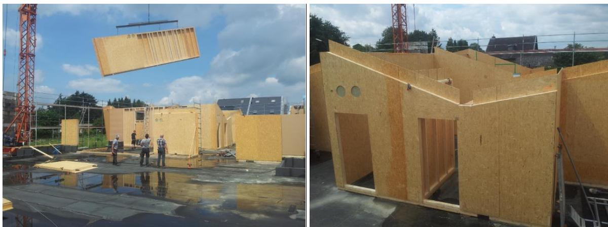
Abbildung 5 und 6: Vorgefertigte Wände werden aufgestellt / Foto U. Graffelder
