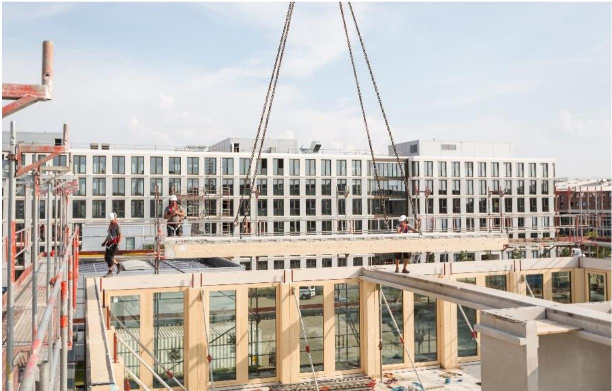
Abbildung 14: «Bürogebäude Handwerkerhaus» Bremen | Montage Deckenelement | © CREE Deutschland GmbH
