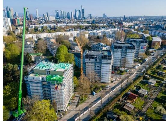
Abbildung 15: Aufstockung von 6-geschossigen Punkthäusern um ein 7. und 8. Geschoss
