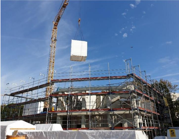
Abbildung 15: Montage Badmodul, Atelier PK Architekten
