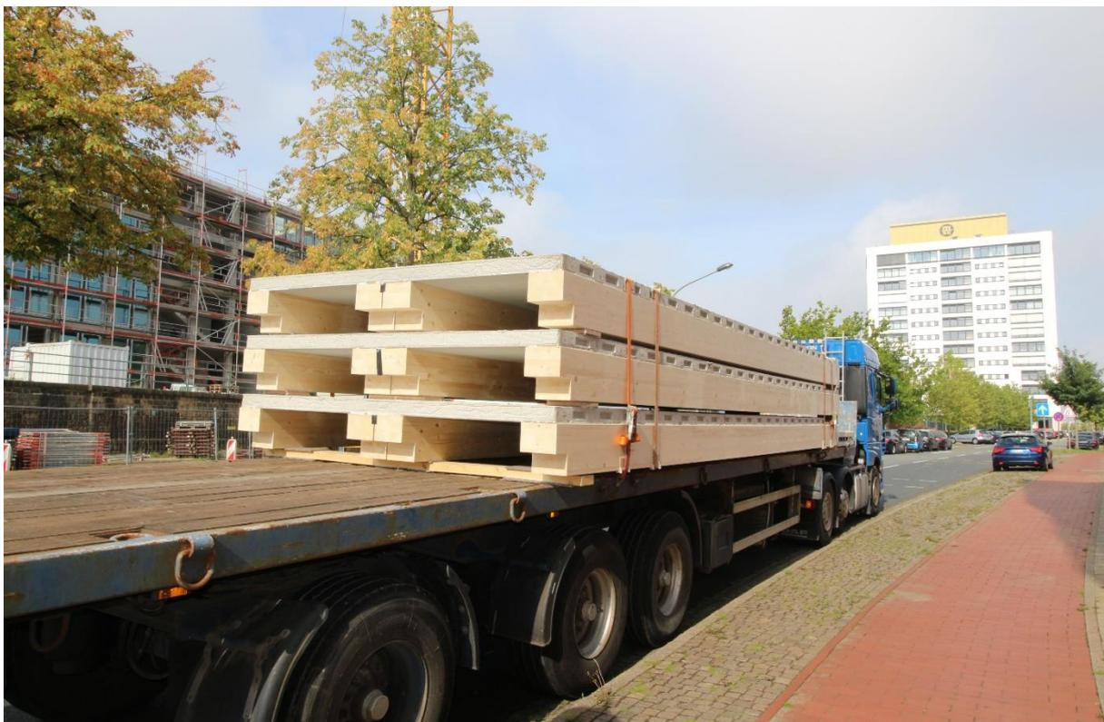
Abbildung 11: «Bürogebäude Handwerkerhaus» Bremen | Logistik Deckenelement | © CREE Deutschland GmbH
