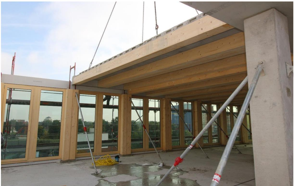
Abbildung 15: «Bürogebäude Handwerkerhaus» Bremen | Montage Deckenelement | © CREE Deutschland GmbH
