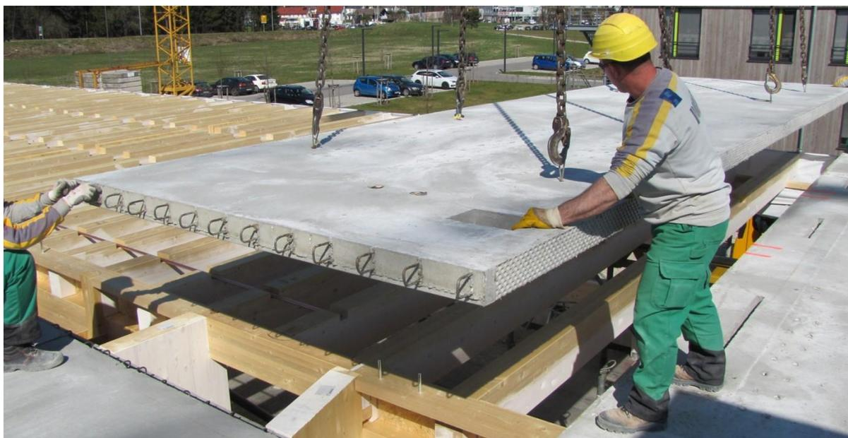
Abbildung 3: Montage Betonfertigteile auf Balkenlage
