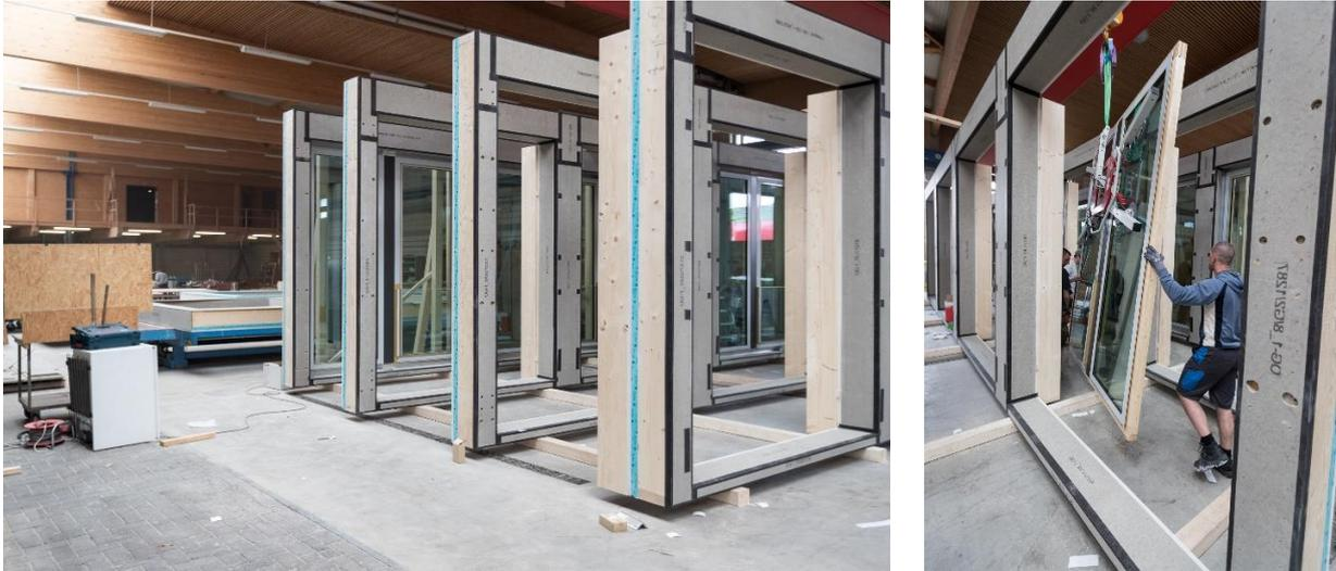
Abbildung 8: «Bürogebäude Handwerkerhaus» Bremen | Vorfertigung Außenwand | © CREE Deutschland GmbH
