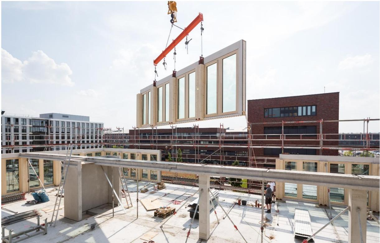
Abbildung 12: «Bürogebäude Handwerkerhaus» Bremen | Montage Außenwand | © CREE Deutschland GmbH
