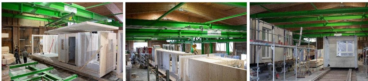
Abbildung 10, 11 und 12: Modulmontage in der Feldfabrik
