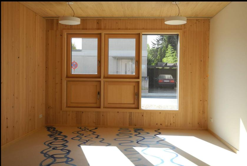
Leimfreie Dübelholzbauweise - Nachtlüftungsflügel
