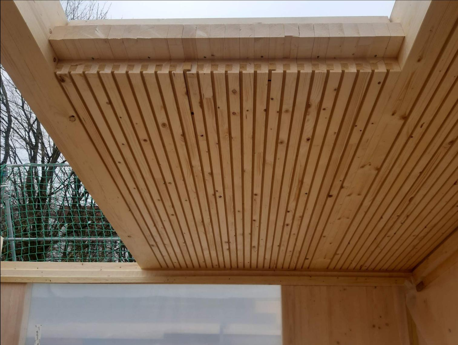
Massivholzdach mit integrierten Holzweichfaserstreifen als Schallabsorber
